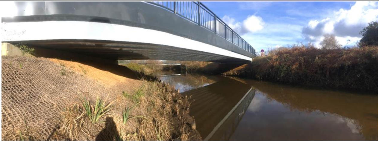
Passage à faune sous le pont Béziers après travaux (CD71)
