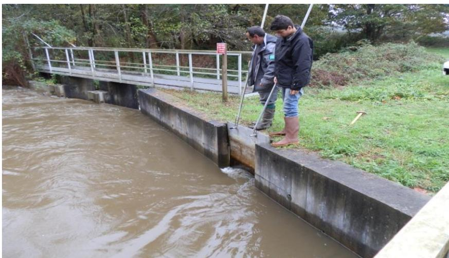
*Manipulation des ouvrages pour ménager le réseau de digues en période de crise hydraulique*
