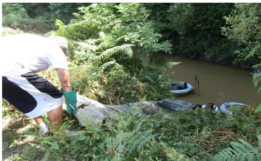
*La pose d'un rouleau de polypropylène permet de diminuer les frottements au cours de la remontée des sacs.*
