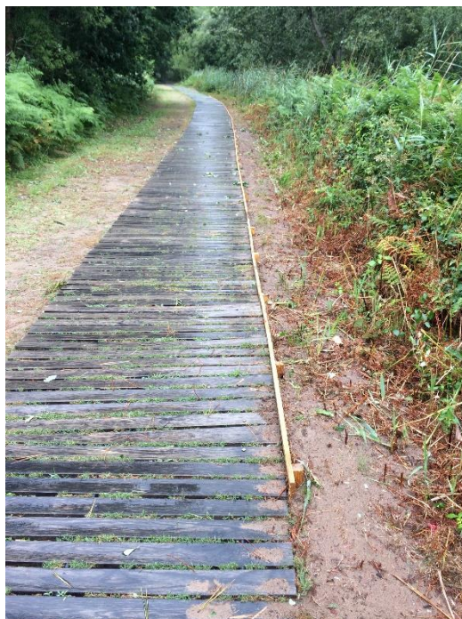
Système Escaladune stabilisé par des planches au circuit de visite.
