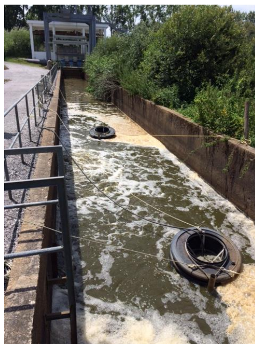
Réalisation d'une piste stabilisée le long du canal d'amenée – Expérimentation avec des aérateurs
